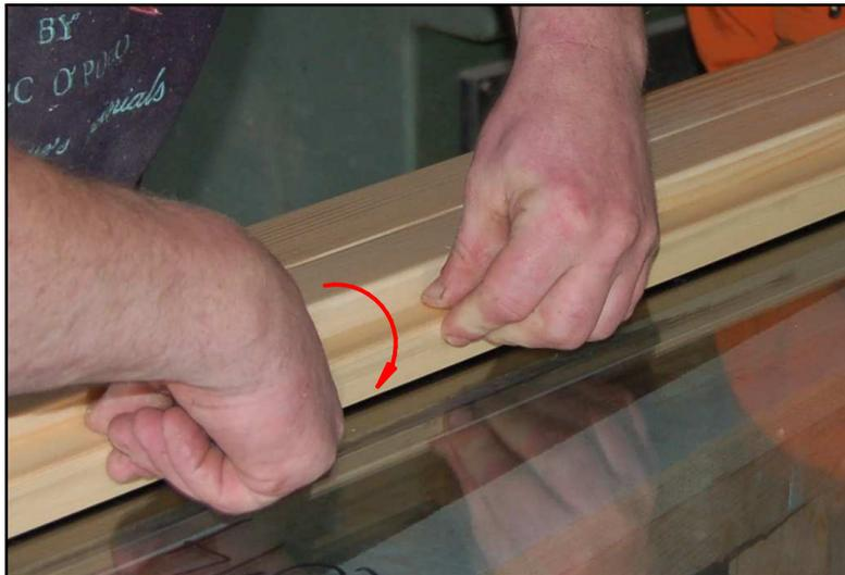
3. Danach vollständig mit Klotzholz ausklipsen und nach außen die Glasleisten einfach entnehmen.
