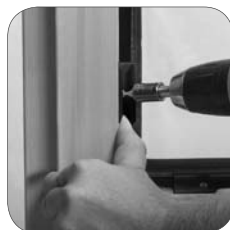
3. FIXclip GLE20 anpressen durch 45° Verschraubung
