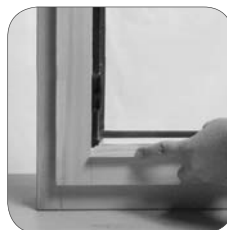
4. Einclippen der Glasleiste
