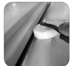
6. Leichte Verarbeitung mit Dichtungsroller
