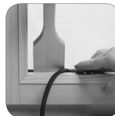
5. Keildichtung einpressen
