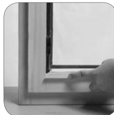
4. Einclippen der Glasleiste
