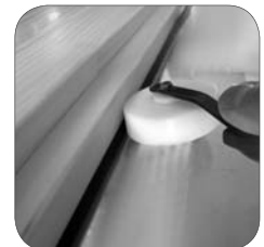
6. Leichte Verarbeitung mit Dichtungsroller
