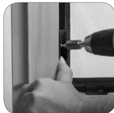
3. FIXclip GLE20 anpressen durch 45° Verschraubung
