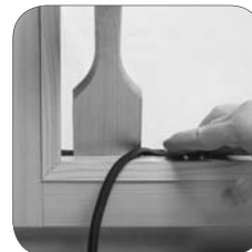
5. Keildichtung einpressen
