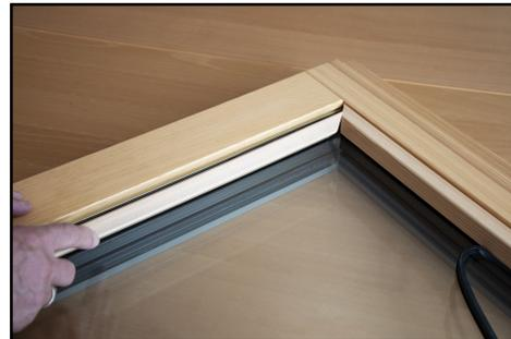
3. Restliche Glasleisten entnehmen und anschließend FIXclip-Schienen abschrauben.
