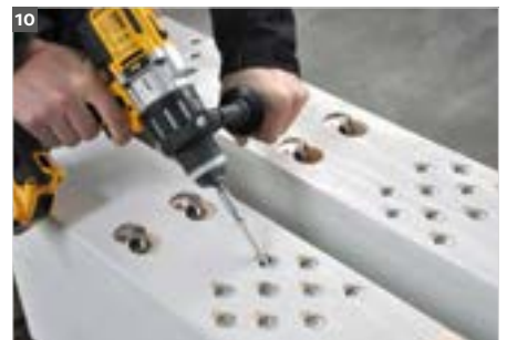
Jonctions de faitage, chevrons-poutres principales, rigides à la flexion avec T-Joint D40/W30.
